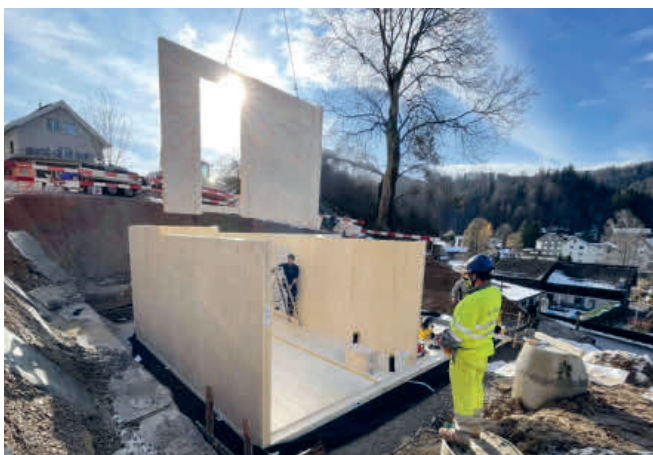
Errichtung eines Kellers aus Holz, Foto: Timbase Schweiz AG
