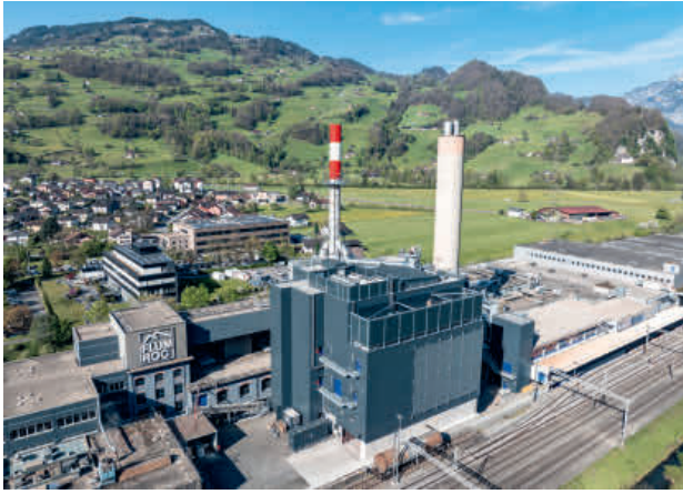
Das neue Ofenhaus wurde während der laufenden Produktion erstellt. Erst in der Schlussphase musste die Produktion für vier Monate eingestellt werden, um den neuen Ofen an die bestehenden Produktionslinien anzuschliessen.
